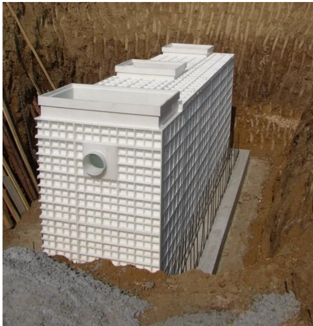
Άποψη ορθογωνικού ελαιοδιαχωριστή πριν τη σκυροδέτηση. Διακρίνονται οι αναμονές του οπλισμού, η πλάκα έδρασης και το εξωτερικό καλούπι (μεταλλότυπος)
